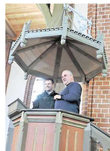
Die etwa 140 Jahre alte Kanzeldeckel wurde restauriert.
